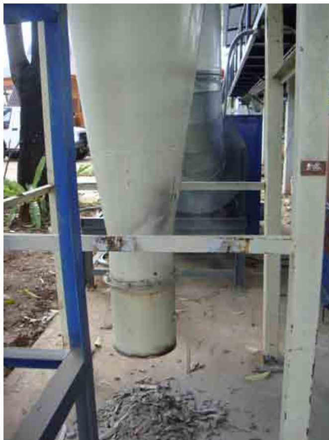
รูปที่ 4-31 ผงฝุ่นและชิ้นมันบางส่วนออกมาทางไซโคลนดักฝุ่น
